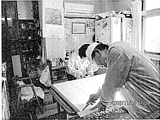
障子の張替え作業
